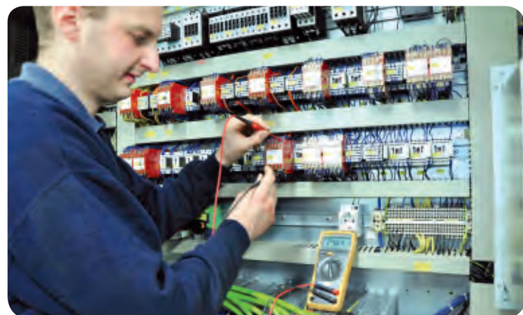
Überprüfung der Leitfähigkeit von Schaltkontakten
